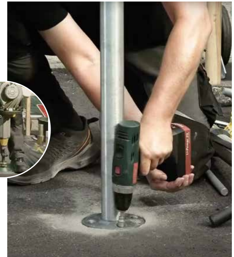
4. Fixez les poteaux de signalisation avec le « kit de serrage ».
