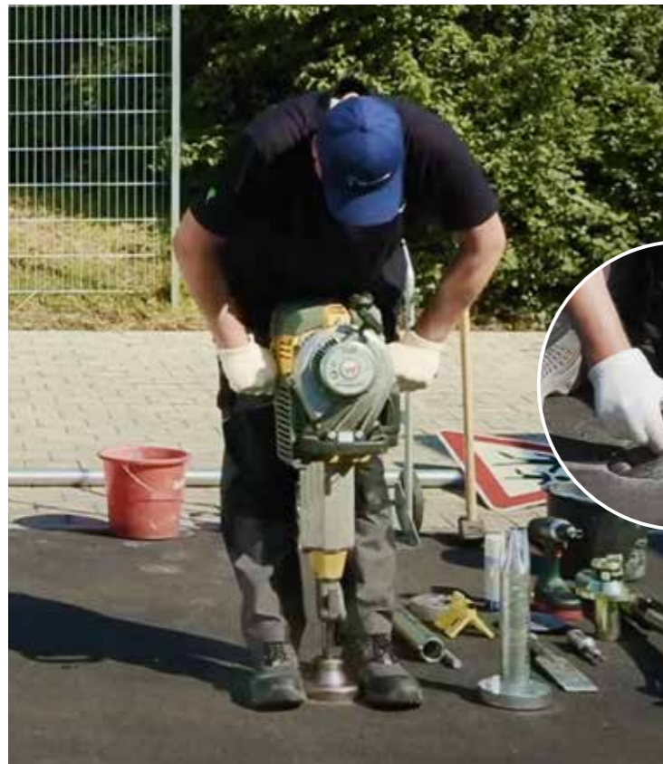
1. Ouvrir la surface avec la cloche de carottage.
