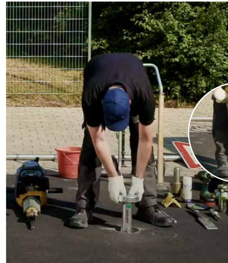
3. Insérez Ferradix et enfoncez-le avec « le mouton de battage ».
