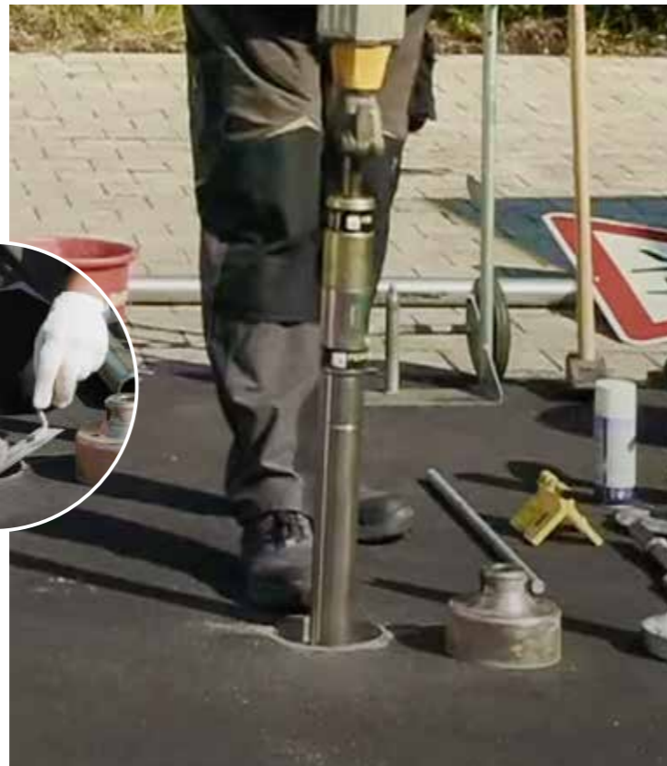
2. Pré-perforer avec un « tube de pré-trou ».
